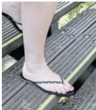
Die Treppenstufen der Brücken wurden aus Sicherheitsgründen vor dem Konzert mit gelbem Signalband versehen.
