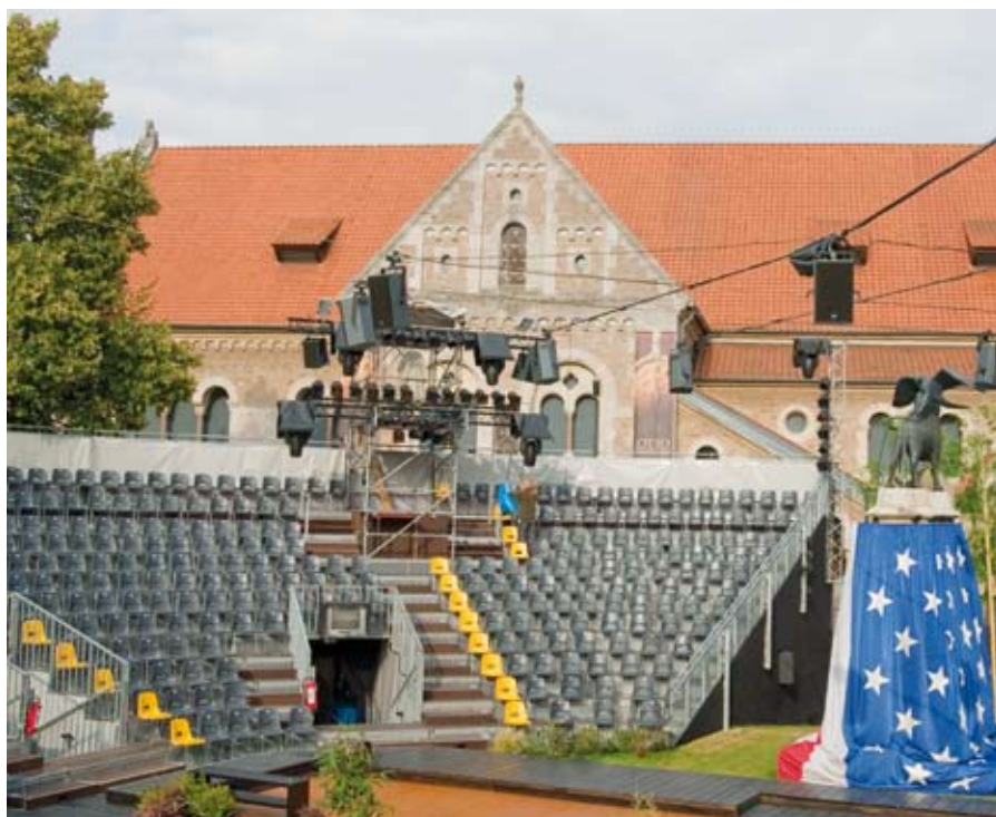
Im Stahlseil-Kreuz hängt die Hauptbeschallung – bestehend aus acht Kling&Freitag CA1001
